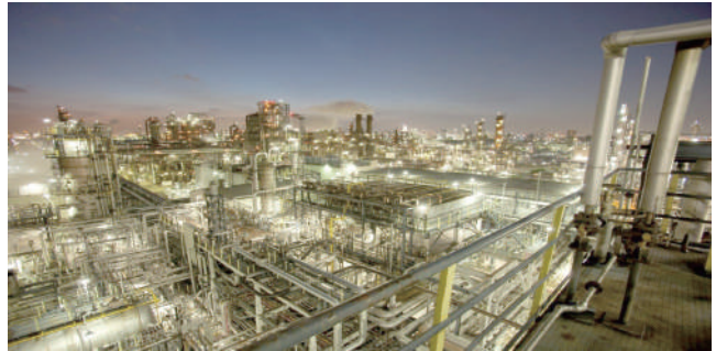
石油精製プラント
