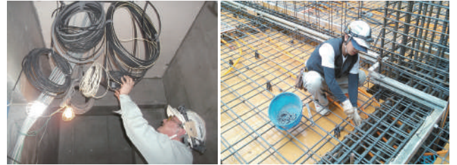
電気工事はビルディングに生命を吹き込む仕事
