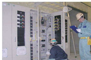
現場作業風景
