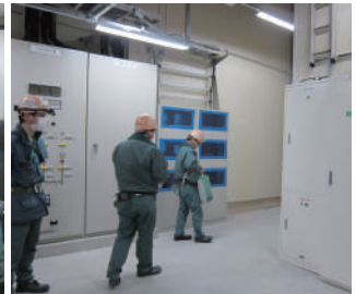
変電設備はビルの心臓部
