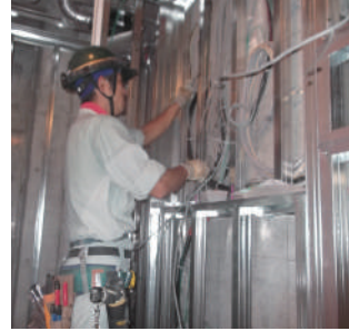
電気設備は先端技術の集積
