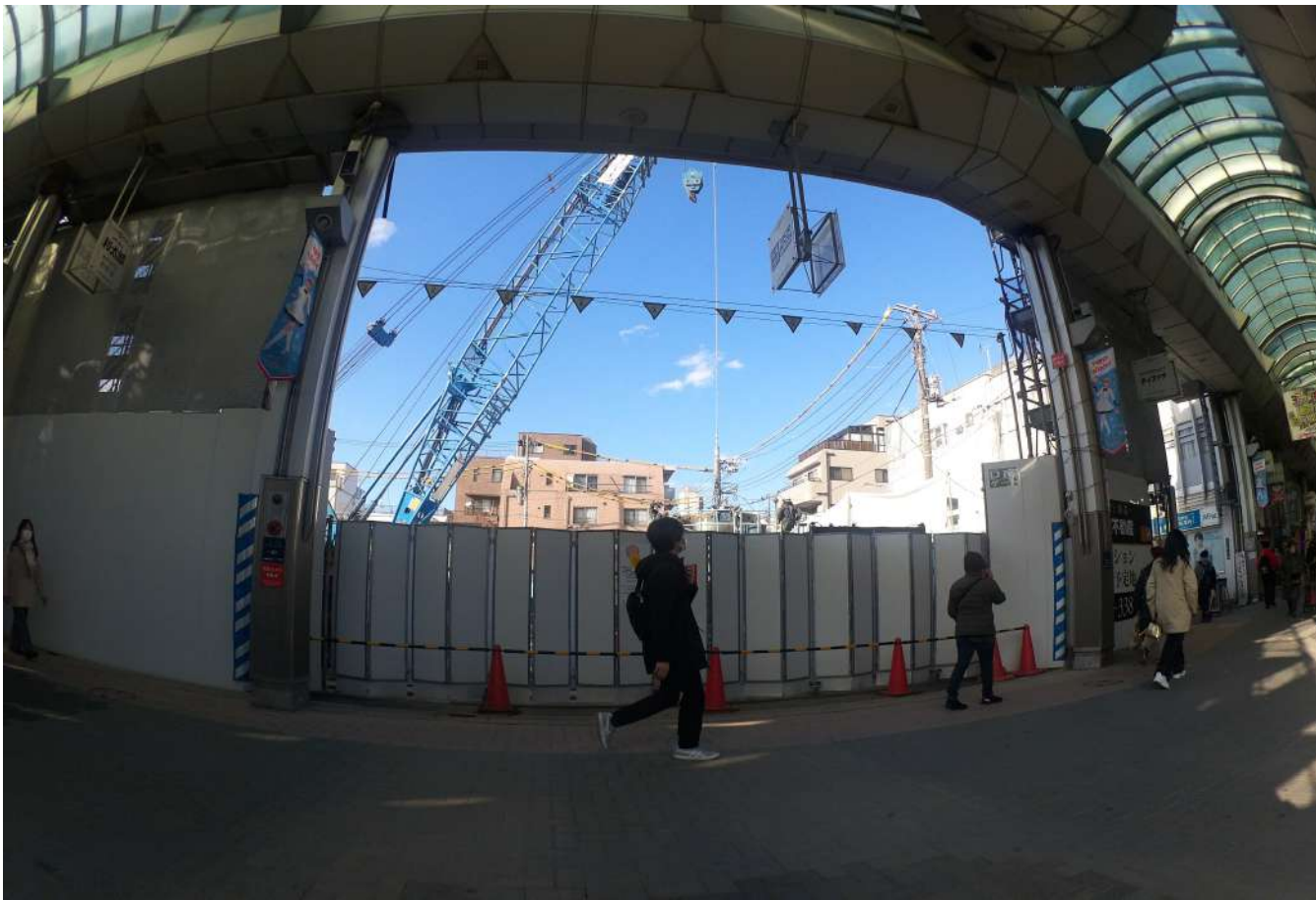
地上 26F のクロスポイントの建設現場は、商店街のアーケードの間からいつもみえている
