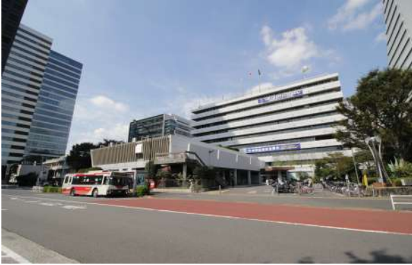
写真1 / 現在の中野区役所は1968年竣工
