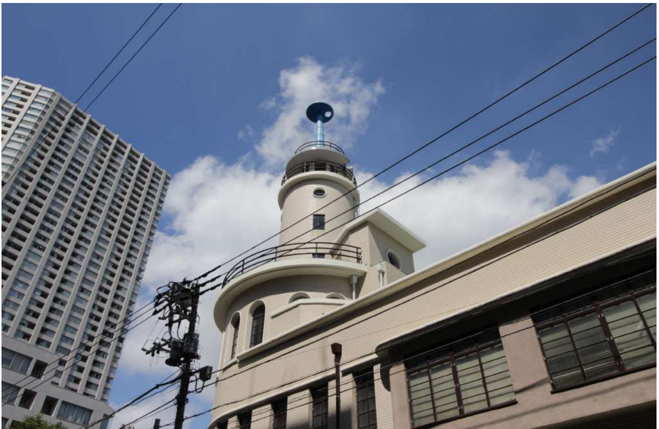
写真2 / 円形講堂のさらに上に建つシンボルタワーは、昭和59年になって後付けされた
