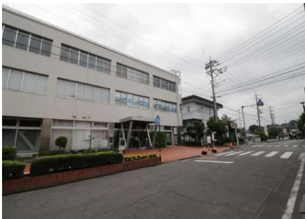
写真2 / 川越火力発電所跡（東京電力川越支社）は中央公民館隣
