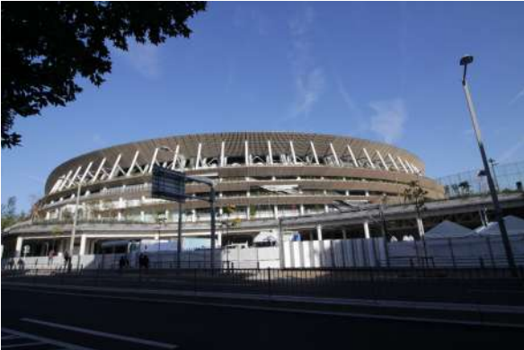
写真①／完成した新国立競技場（2019年12月）
